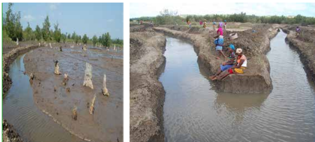
Figura 14. Canal aberto para permitir a circulação da água, com apoio da comunidade (Fotografia, Henriques Balidy)
