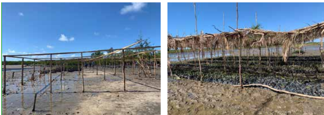
Figura 15. Estufa em construção (A) e estufa com cobertura de material local (B)
